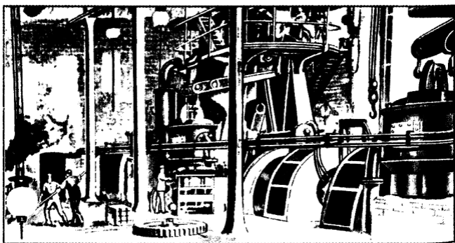
Машинный зал центральной электростанции в Берлине. 1890 г.
